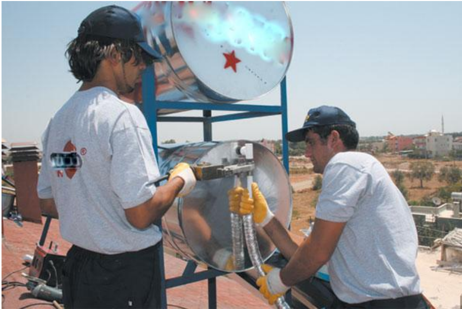
Resim 3.18: Kullanma sıcak suyu boyler çıkış bağlantısı yapılması Kullanma sıcak suyu havalık bağlantısı yapılır
