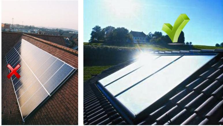
Resim 3.12:Yanlış ve doğru çatı yerleşimleri
