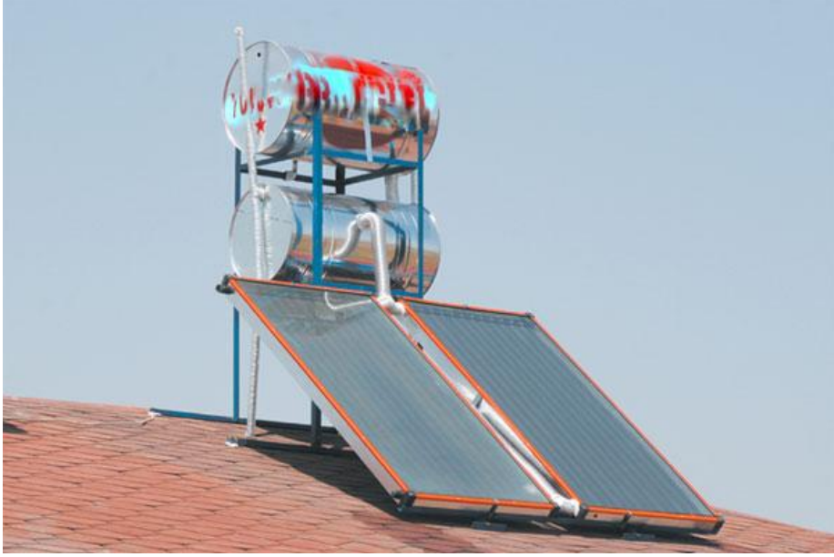
Resim 3.21:Montajı bitmiş güneş enerjisi sistemi
