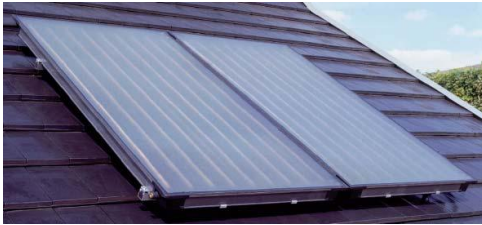
Resim 3.9: Çatı Üstü uygulaması
