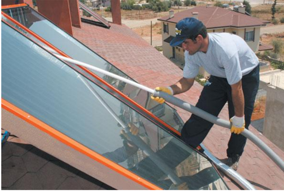
Resim 3.20: Boru izolasyonunun yapımı
