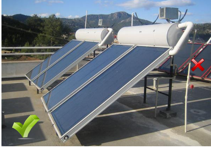
Resim 3.11:Güneş enerjisi kolektör açıları
