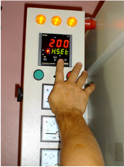
Resim 5.3: Fırın sıcaklık ayarlarının yapılması
