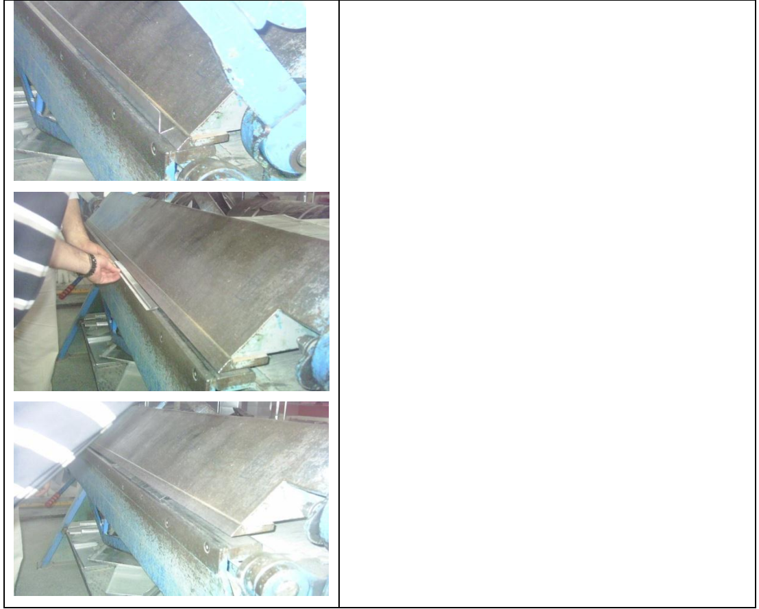
Makine ile kenet yapımı
