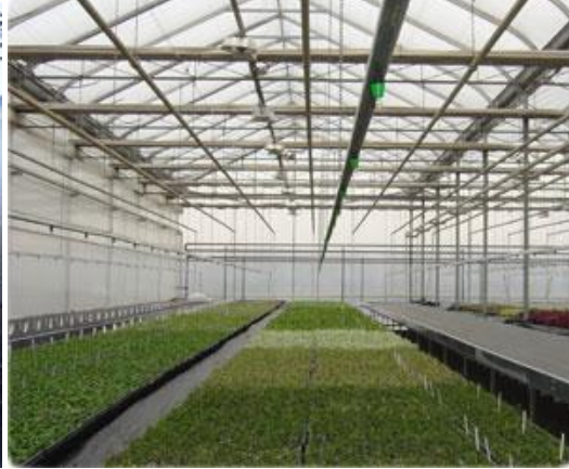
Resim 2.23: Tavana aslı tip üstten yağmurlama sistemi
