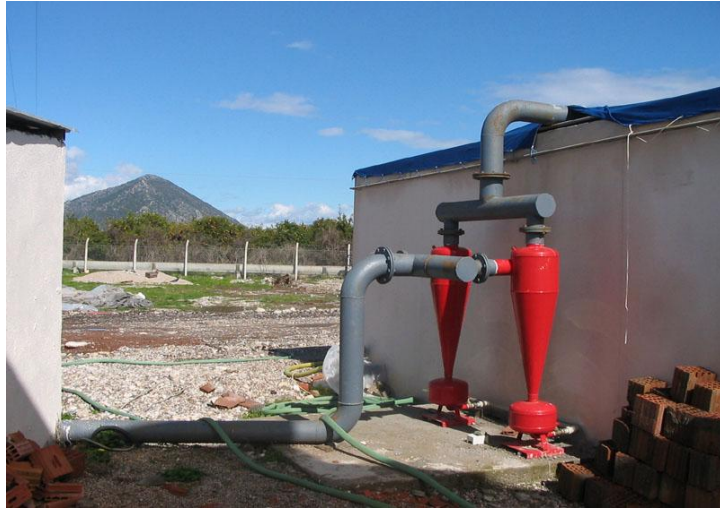
Resim 2.29: Kum tutucu (hidrosiklon)
