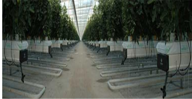
Resim 2.12: Tezgâh altı borulu ısıtma sistemi
