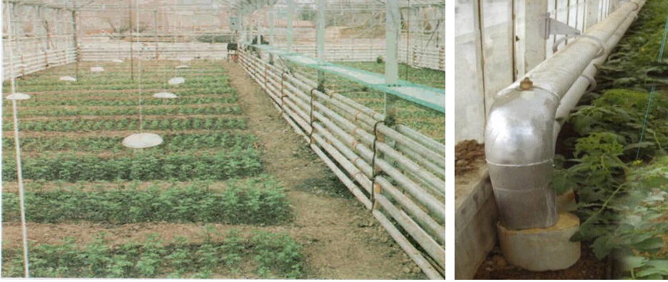
Resim 2.10: Yan duvar boru sistemi
