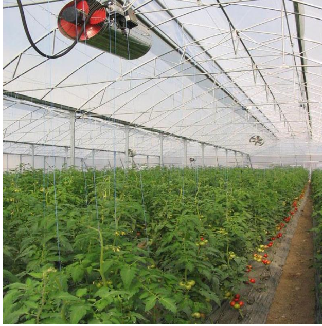
Resim 2.17: Elektrikli ısıtıcı
