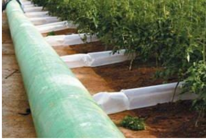
Resim 2.14: Sıcak hava ile ısıtma sistemi
