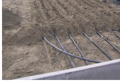
Resim 2.13: Toprak içi ısıtma sistemi
