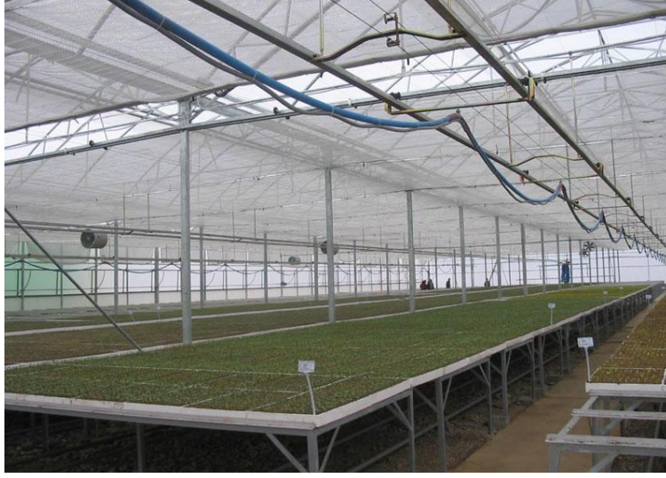
Resim 2.24: Hareketli üstten yağmurlama sistemi
