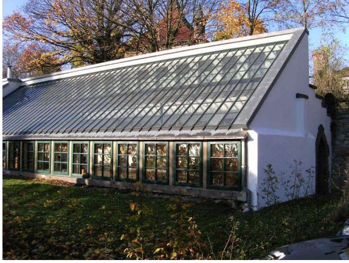
Resim 1.28: Tek meyilli çatılı sera
