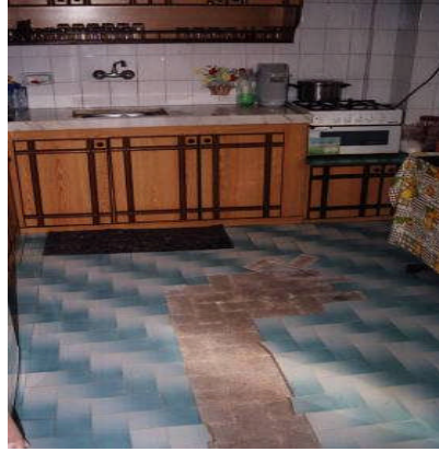
Resim 1.16: Yüzeyin ıslatılmamasından kaynaklanan hata
