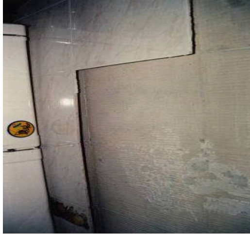
Resim 1.10 :Raf ömrü geçmiş hazır harçtan kaynaklanan hasar
