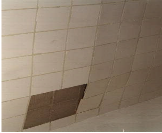
Resim 1.15: Karoların ıslatılmamasından kaynaklanan hata
