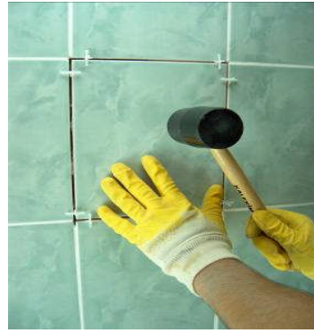
Resim 2.12 : Hasarlı karonun yenisi ile değiştirilmesi
