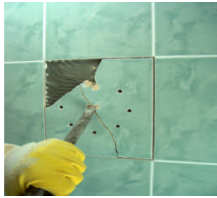
Resim 2.3: Karonun kırılması
