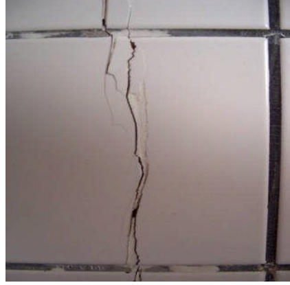
Resim 1.21 : Depremden kaynaklanan hata
