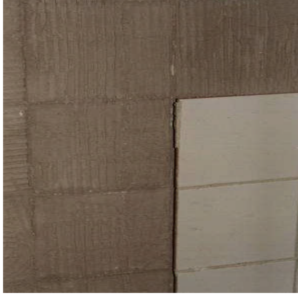
Resim 1.11: Yapıştırma harcından kaynaklanan hata
