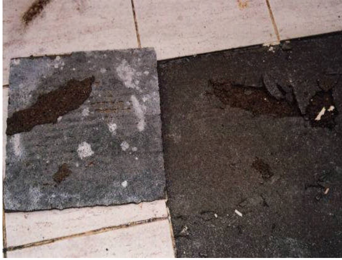
Resim 1. 6: Çimento harcının içerisine katılan kireçten kaynaklanan hata
