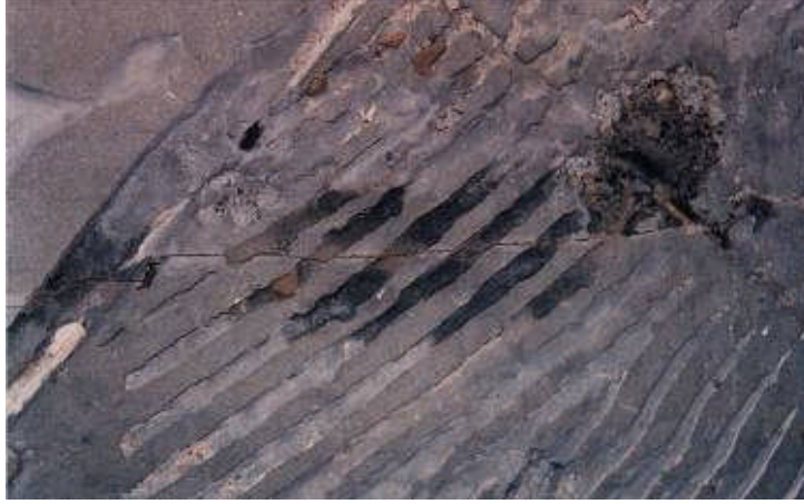
Resim 1.1: Yüzey tesviye hatasından kaynaklanan seramik düşmesi
