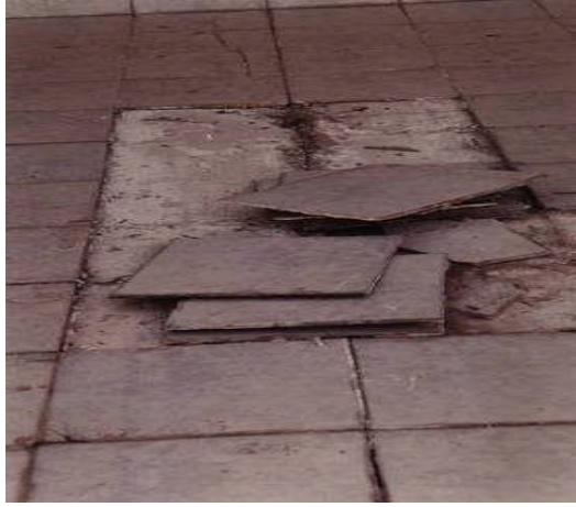
Resim 1.19: İklim şartlarından kaynaklanan hata
