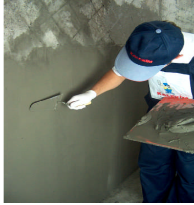
Resim 2.11: Yüzeyin tamir harcı ile onarılması
