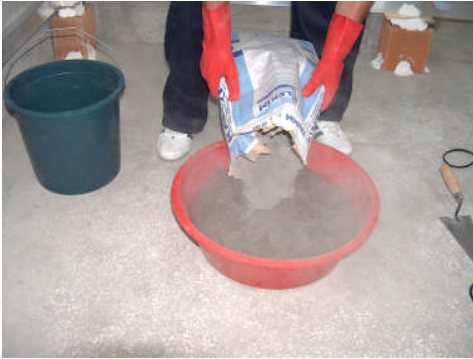
Resim 2. 9 : Yapıştırma harcının hazırlanması
