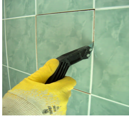
Resim 2.1: Derz boşluklarının boşaltılması
