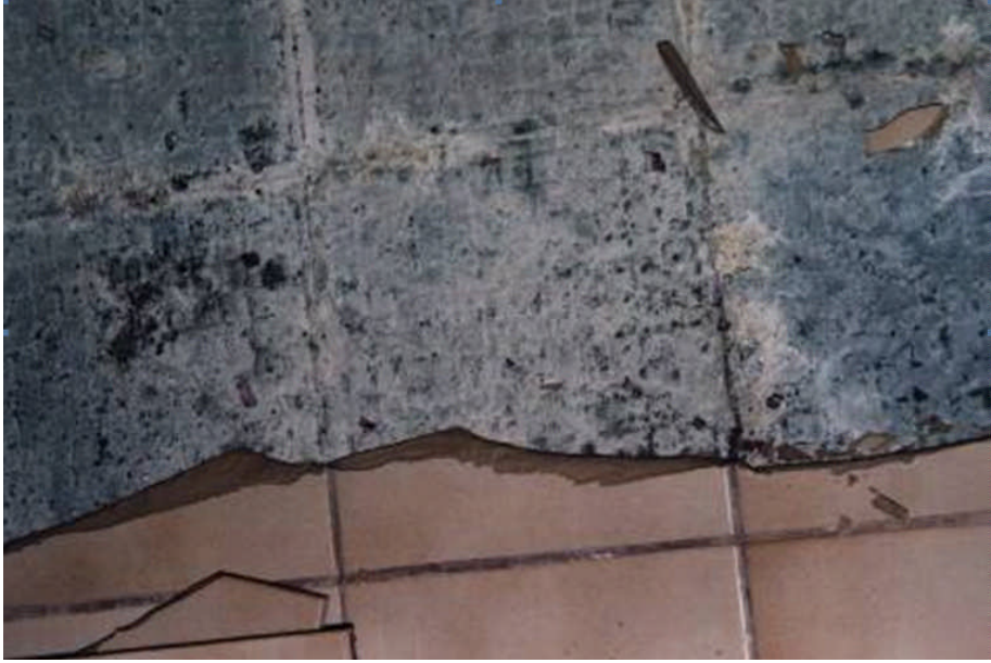
Resim 1. 2: Kireçli bir sıva (tesviye tabakası) üzerine yapılmış seramik karo kaplama
