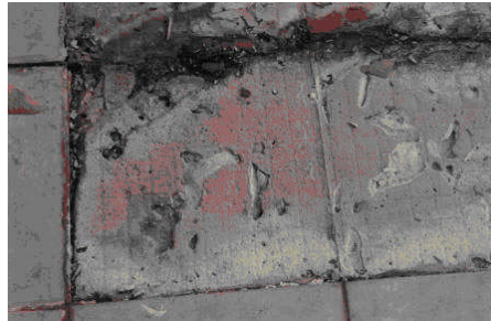
Resim 1.17 : Seramik karoların tokmaklanmamasından kaynaklanmış hata
