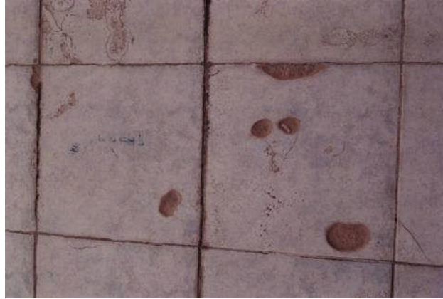
Resim 1.13: Derzlerde çimento kullanımından kaynaklanan hata
