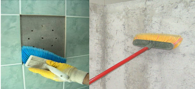
Resim 2.7: Yüzeyin tozunun alınması
