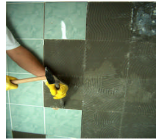
Resim 2.4: Seramiklerin sökülmesi
