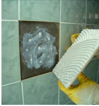
Resim 2.12 : Hasarlı karonun yenisi ile değiştirilmesi
