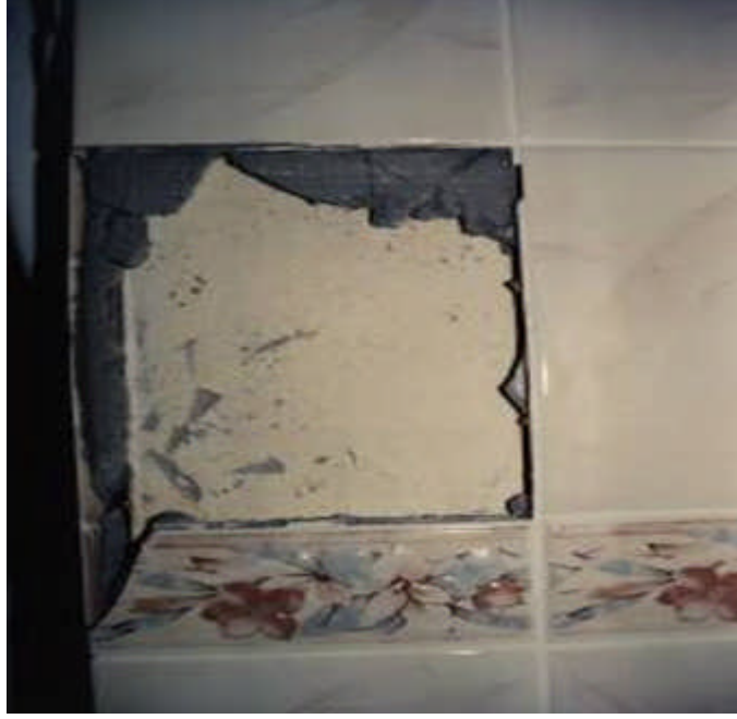
Resim1.3: Yüzeiden kaynaklanan hata
