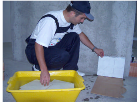
Resim 2.10 : Seramiklerin hazırlanması
