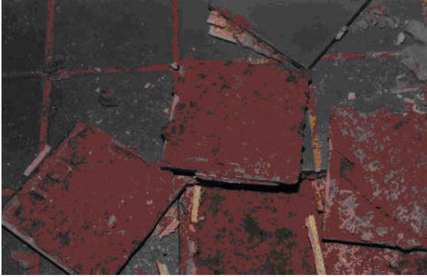
Resim 1.18 :Derz doldurmadan kaynaklanan hata
