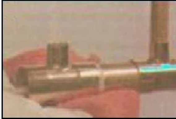
Resim 1.14: Dekapanın fazlalıklarının bezle temizlenmesi
