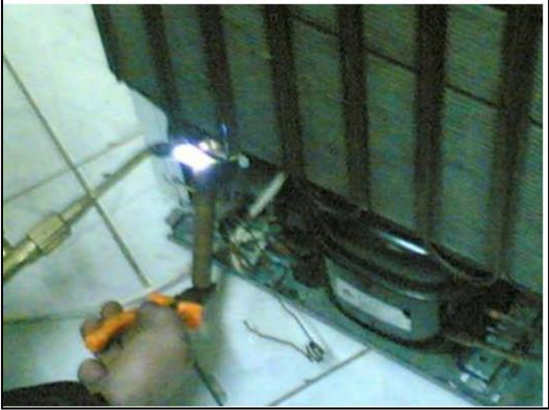
Resim 1. 4: Bakır borunun gümüř kaynaęı ile birleřtirme iřlemi
