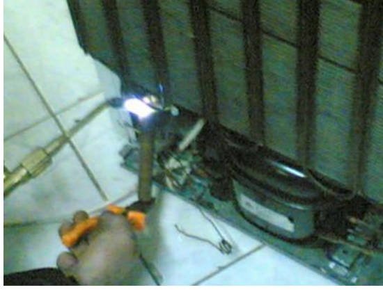
Resim 1.15: Bakır borunun gmř kaynađı ile birleřtirme iřlemi
