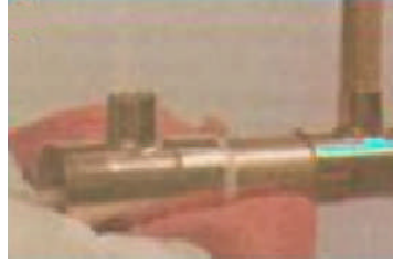
Resim 1.19-7: Dekapanın fazlalıklarının bezle temizlenmesi
