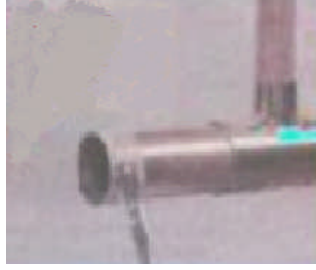
Resim 1.19-6: Boru ek yerine dekapan sürülmesi
