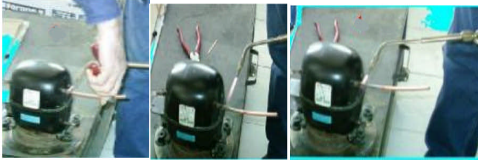
Resim 1.23: Bakır borunun dekapan sürülerek yerleştirilmesi ve bakır boru tavlama
