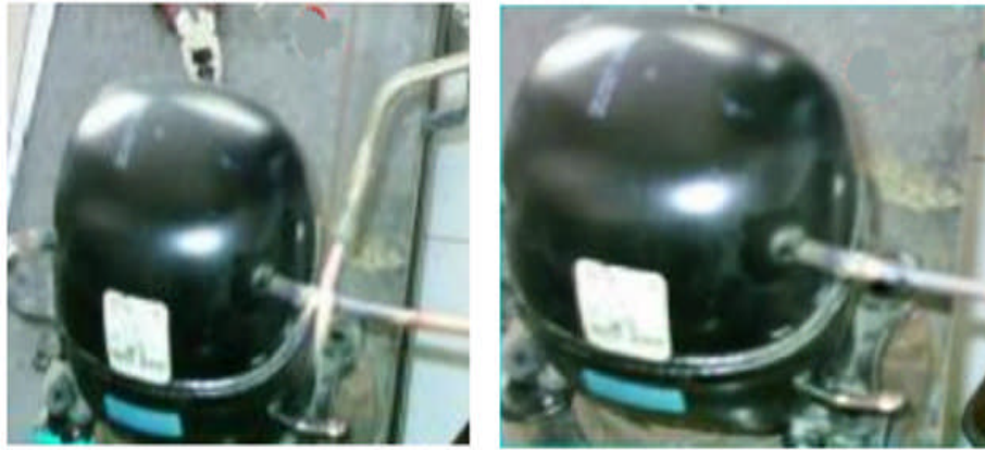
Resim 1.24: Ekovat borusunun kaynatılması
