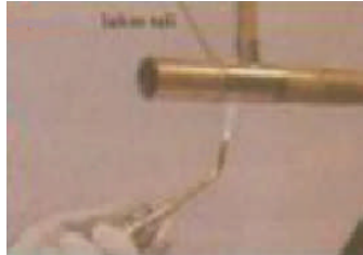
Resim 1.19-8: Boruya lehim teli ile kaynak yapılması
