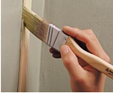
Resim 2.3: Vernik uygulama araçlarından fırçalar ve vernik uygulanması
