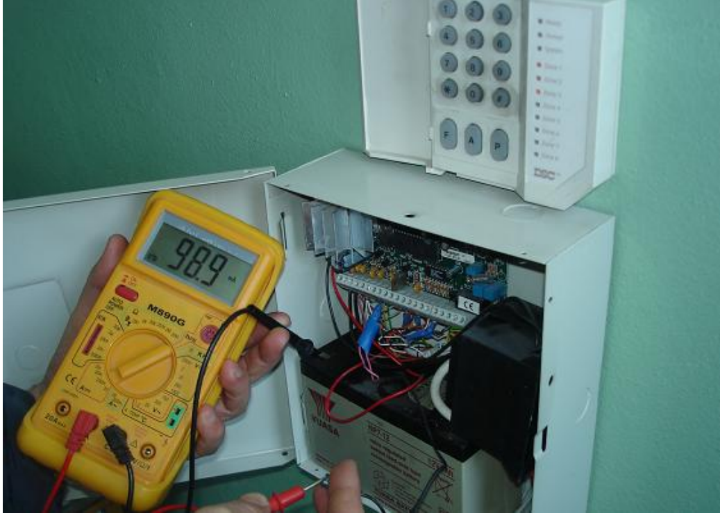
Şekil 1.9: Soygun alarm sisteminde akım ölçmek
