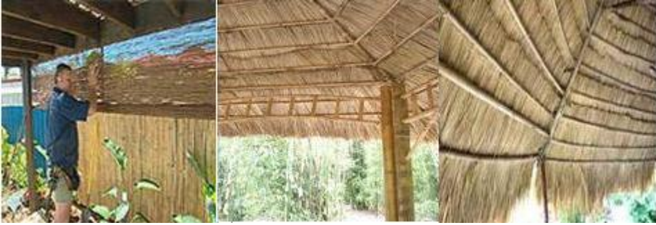
Resim 4.7: Hasır otunun duvar ve kamelya tavanında kullanımı
