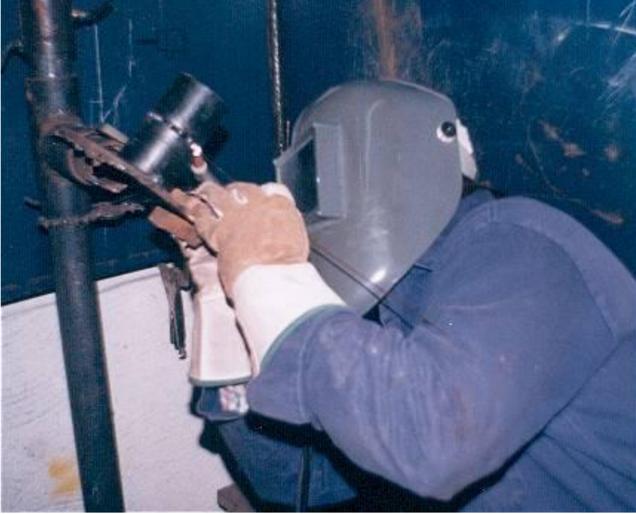
Resim 1.1. TIG kaynağıyla boruların birleştirilmesi
