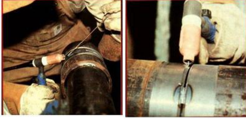
Resim 3.5: TIG boru kaynağında elektrot tutuluşunun önden ve yandan görünüşü
