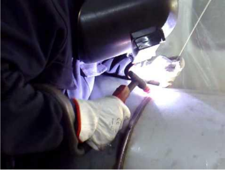
Resim 1.5. TIG kaynağıyla boruların birleştirilmesi
