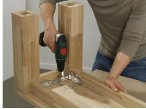
Resim 2.20: Ayak bağlantı demiriyle ayak montajı
