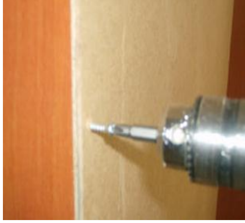
Resim 1.24: Arkalığın vidayla sabitlenmesi Kanal içerisinde yapılan arkalığın takılması Resim 1.25’de gösterilmiştir.
