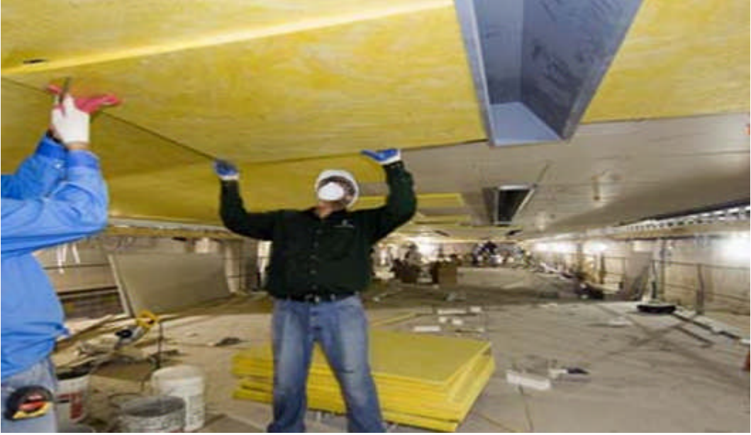
Resim 3.11:Tavan yalıtım malzemelerinin döşenmesi
