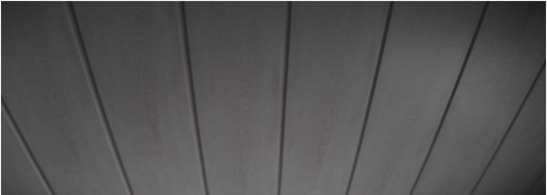
Resim 2.4: Tavan kaplamasında kullanılan ağaç desenli yapay reçine emdirilmiş plakalar
