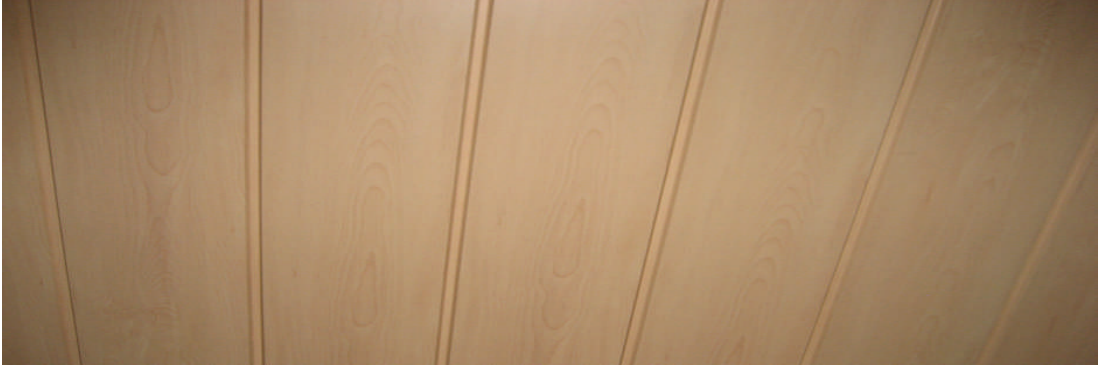
Resim 2.3: Tavan kaplamasında kullanılan ağaç desenli yapay reçine emdirilmiş plakalar
