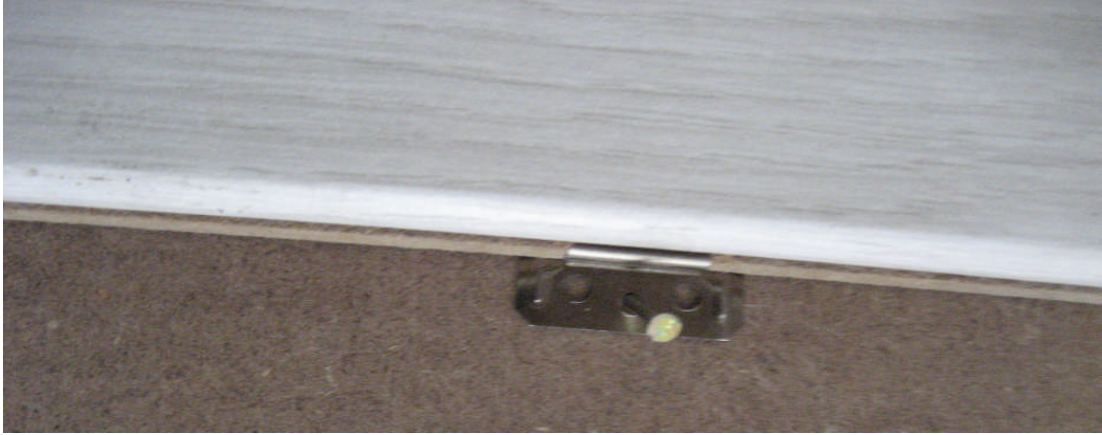
Resim 3.8: Özel bağlantı gereciyle tavan montajı
