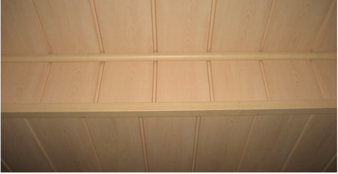
Resim 3.15: Tavan ve duvar birleřme yerlerinin pervazla kapatılması
