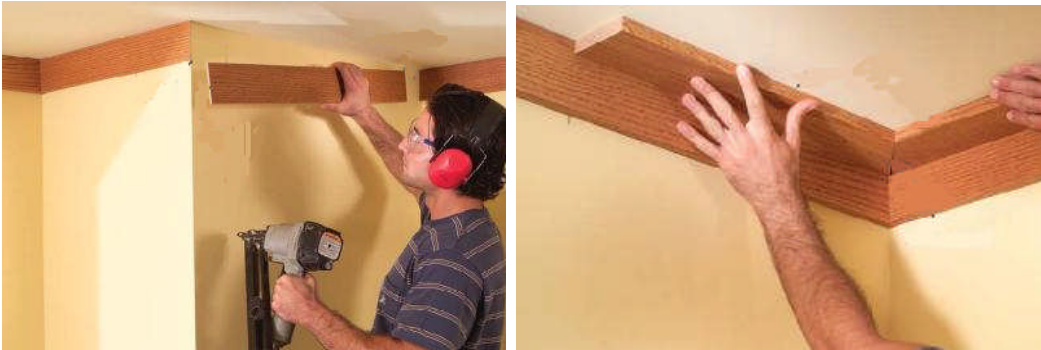
Resim 3.16: Tavan ve duvar bitiřlerinin pervazla kapatılması
