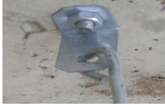
Resim1.9: Metal asma tavan bağlantı sistemleri
