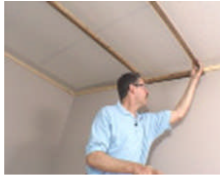
Resim 3.2: Bitişik tavan alt konstrüksiyonunun bağlanması
