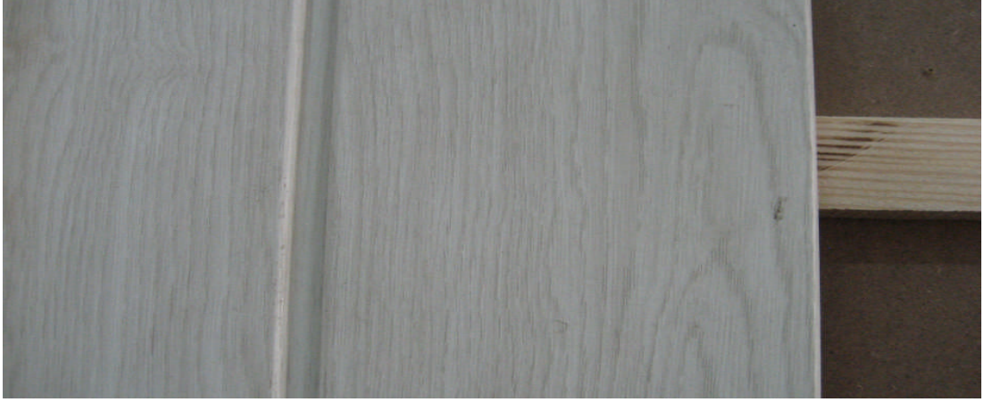
Resim 3.9: Özel bağlantı gerecinin gizlenmesi
