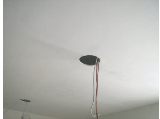
Resim 3.10: Alt konstrüksiyon ve elektrik tesisatının tavadaki uygulamaları
