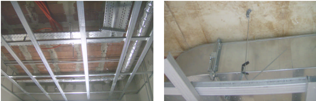
Resim 3.6: Havalandırma ve alt karkas sistemlerinin bağlanması
