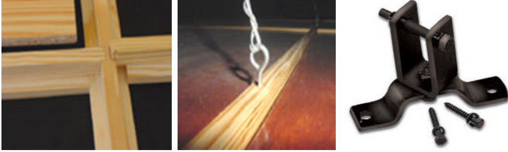
Resim 3.7: Asma tavan birleşme elemanı ve karkasın tavana asılması
