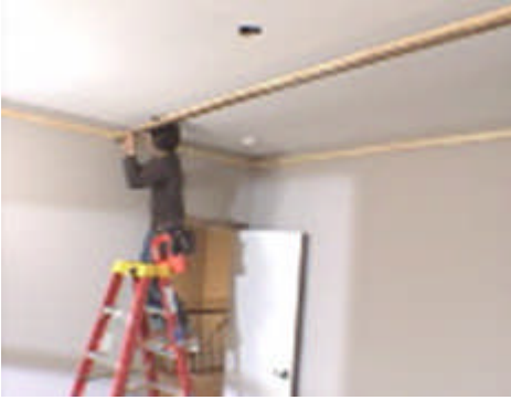
Resim 3.2: Bitişik tavan alt konstrüksiyonunun bağlanması
