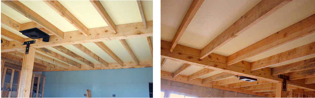
Resim 2.1: Bitişik tavan alt konstrüksiyonları
