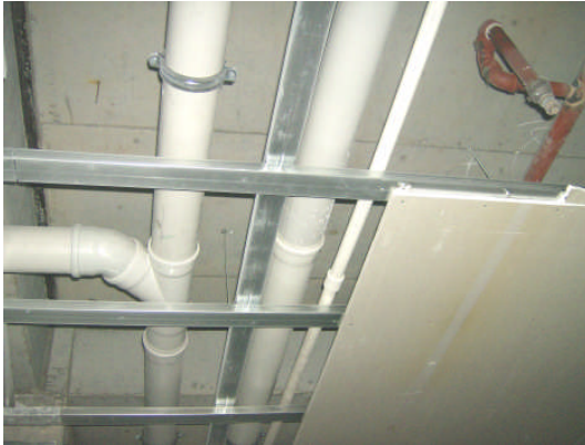
Resim 3.10: Alt konstrüksiyon ve elektrik tesisatının tavadaki uygulamaları
