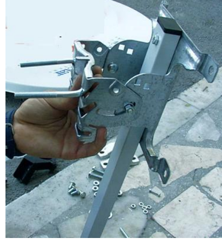
(b) Kelepçe saplamalarının takılması
