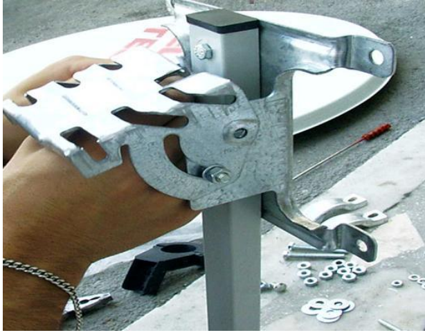
(a) Mekanizma kollarına civata takılması
