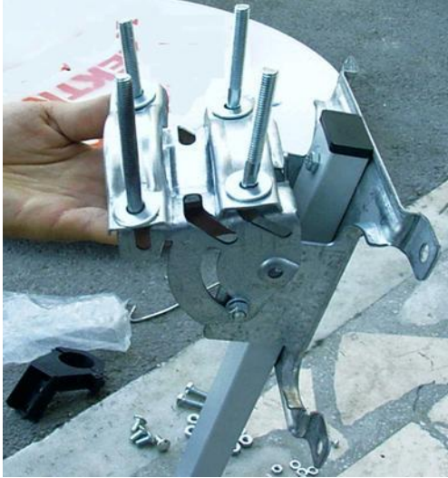
(c) Saplamalara kelepçelerin takılması
