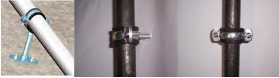
Resim 2.6: Borulara yatay ve dikey konumda kelepçe montajı
