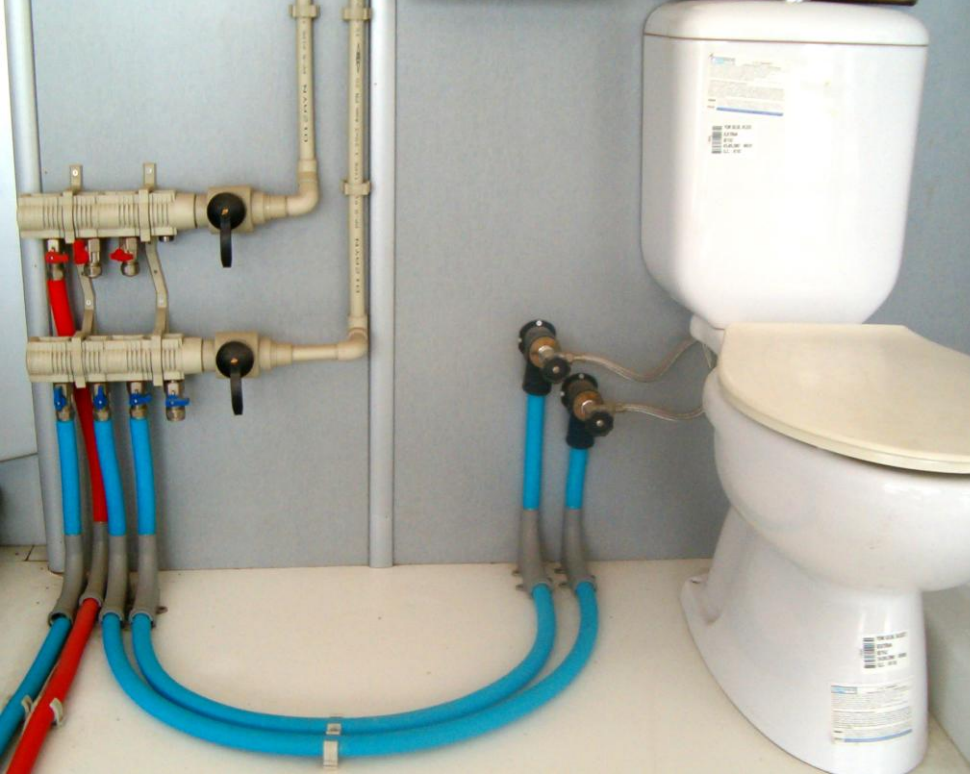
Resim 5.9: Musluk bağlantı şekli
