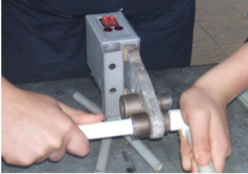
Resim 2.28: Füzyon kaynağında borunun uygun paftada 230 °C–250 °C ısıtılması
