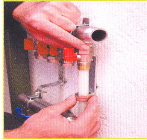
Resim 5.11: Boruların kollektöre yüzlü rakorla birleştirilmesi
