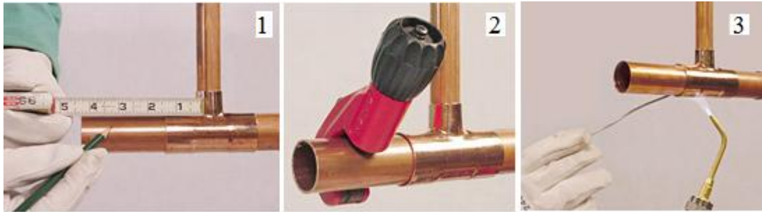
Resim 2.23: Bakır boruların lehimle birleştirilmesi
