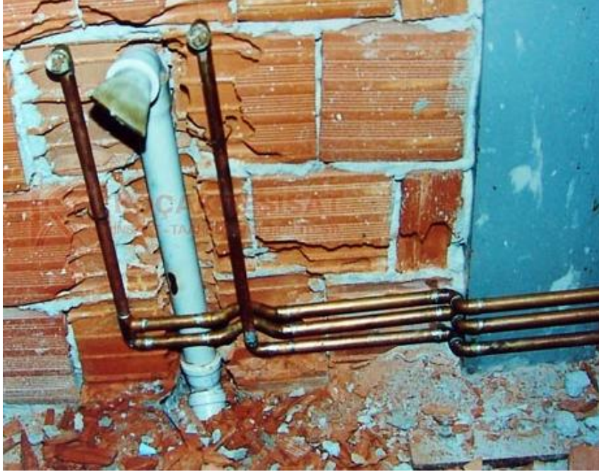
Resim 2.18: Bakır boru ile ankastre temiz su tesisatı yapımı
