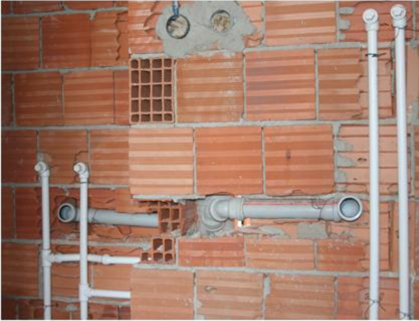
Resim 2.1.: Bina içi ankastre sıhhi tesisat yapımı, temiz su ve pis su boruları
