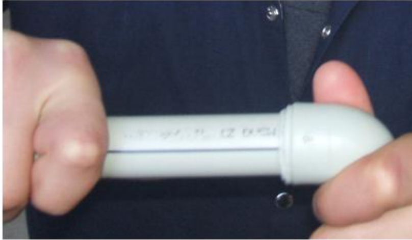
Resim 2.29: Füzyon kaynağında borunun dirsek parçasıyla birleştirilmesi
