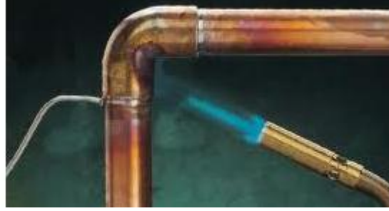
Resim 2.17: Bakır boru ile tesisat yapımı
