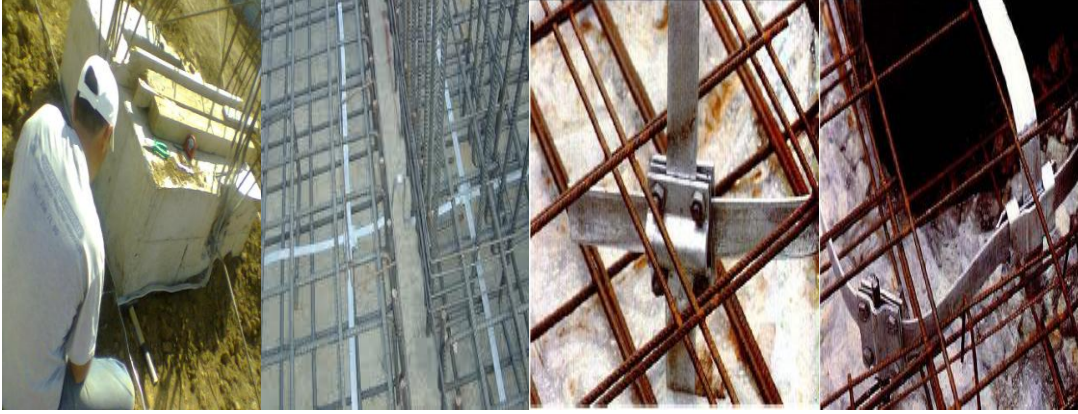
Resim 1.4: Temel Topraklaması galvaniz şeritlerin montajı
