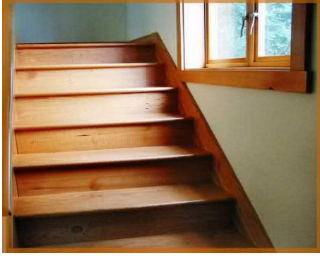
Resim 1.4: Ahşap döşeme ve giriş
