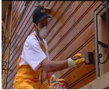
Resim 2.30: Verniğin yüzeye sürülmesi
