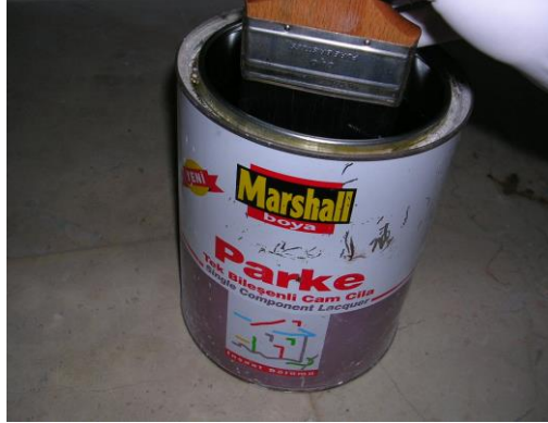
Resim 2.27: Fırçanın verniğe batırılması
