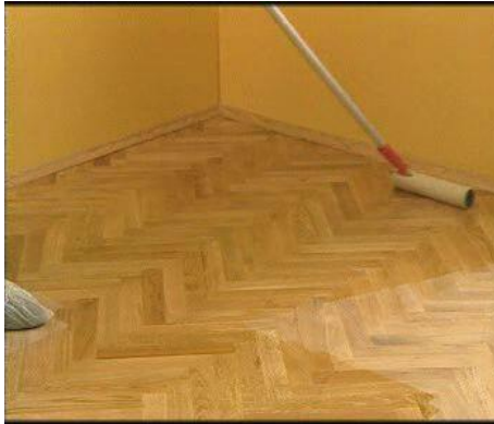
Resim 3.4: Yüzeyin verniklenmesi
