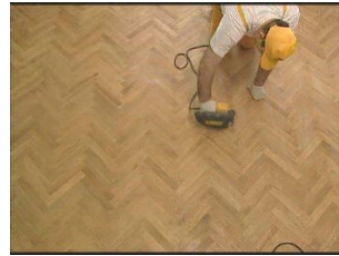
Resim 2.15: Yüzeyin zımparalanması
