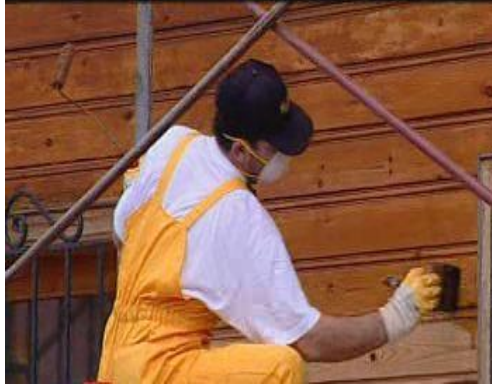
Resim 2.29: Fırçanın lif yönünde kullanılması
