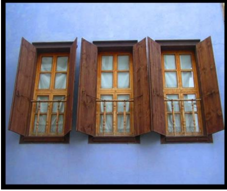
Resim 2.2: Ahşap pencere ve panjur
