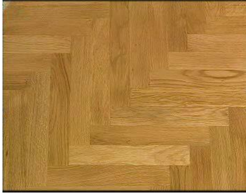
Resim 3.10: Tüm yüzeyin verniklenmesi
