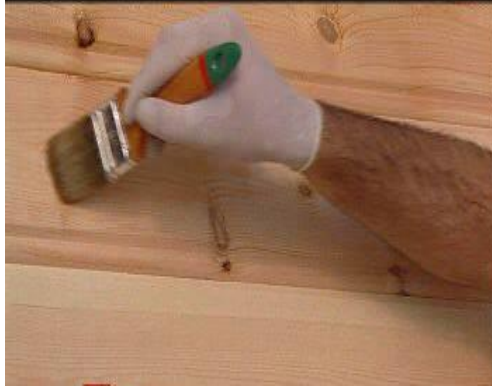
Resim 2.8: Ahşap koruyucunun yüzeye uygulanışı
