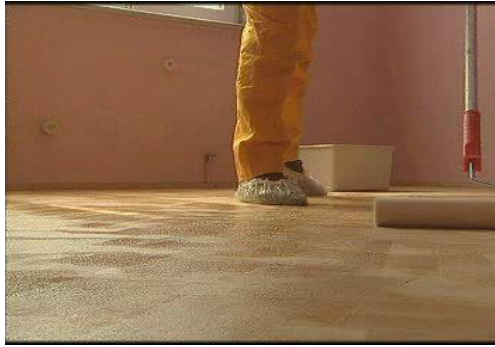
Resim 3.7: Yüzeyin verniklenmesi
