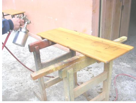
Resim 4.10: Tabancayla yüzeyin verniklenmesi
