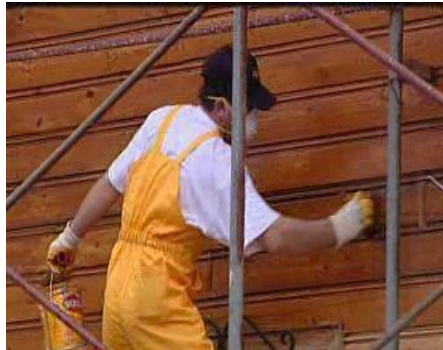
Resim 2.31: Verniğin yüzeye yayılması
