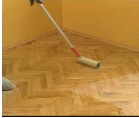
Resim 3.5: Yüzeyin dolgu verniğiyle kaplanması
