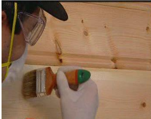
Resim 2.10: Fırçanın lif yönünde kullanılması
