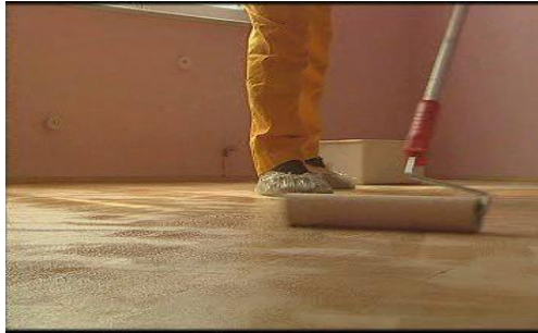
Resim 3.8: Rulo ile vernik yapılması
