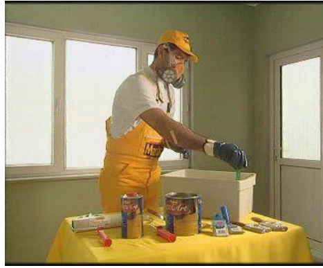
Resim 1.13: Vernik ve tinerin karıştırılması
