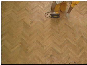
Resim 2.14: Yüzeyin zımparalanması
