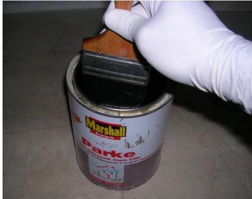
Resim 2.28: Fırçadaki fazla verniğin alınması
