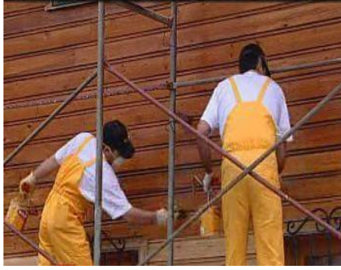
Resim 2.32: Yüzeyin verniklenmesi
