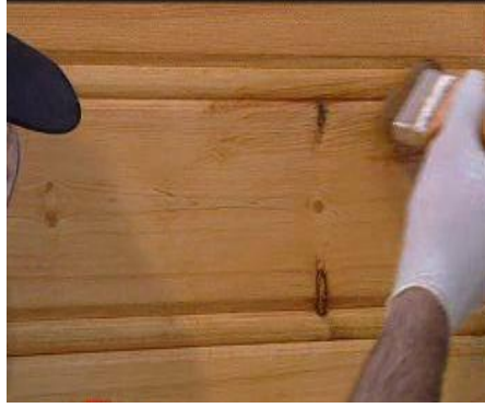
Resim 2.22: Verniğin yüzeye sürülmesi
