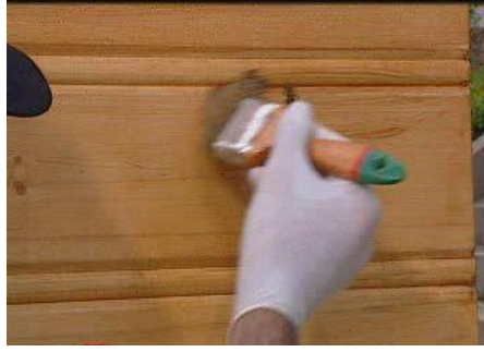
Resim 2.23: Verniğin yüzeye yayılması
