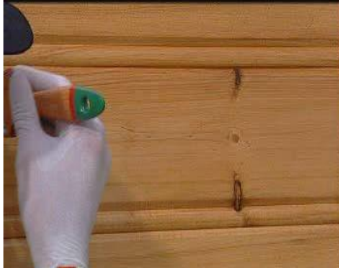
Resim 2.24: Yüzeyin verniklenmesi
