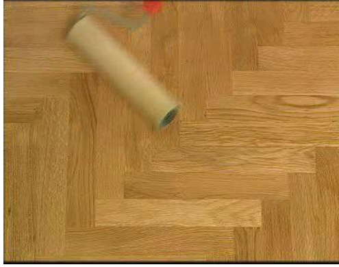
Resim 3.9: Yüzeyin vernikle kaplanması
