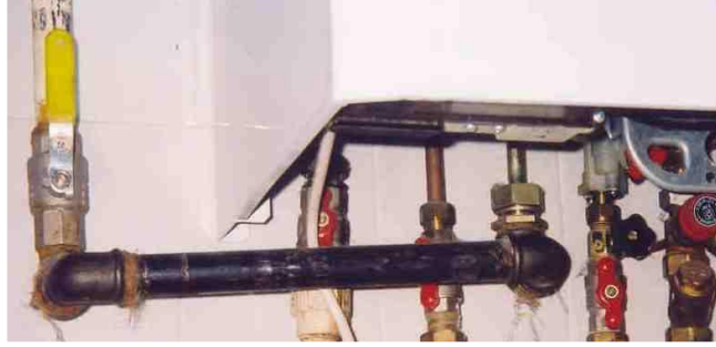
Resim 3.3 : Rijit gaz bağlantısı
