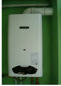
Resim 1.3: Kombi gaz bağlantısı
