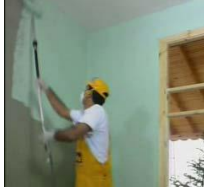
Resim 3.4: Astarın rulo ile sürülmesi
