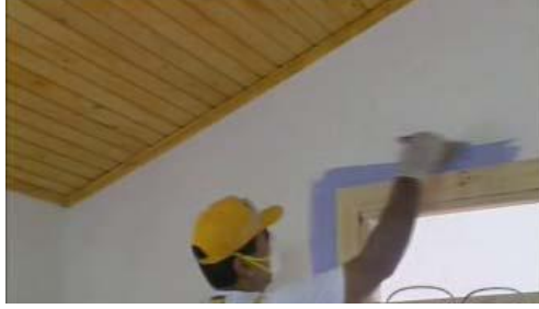
Resim 3.23: Pencere ve köşelerin kestirilmesi
