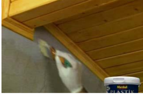
Resim 3.3: Astarın kestirme fırçası ile sürülmesi
