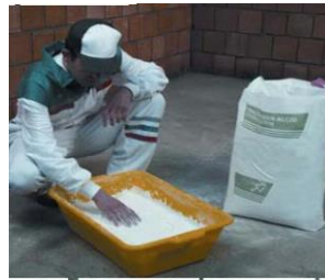
Resim 1.13: Bekleme ve harcın demlenmesi
