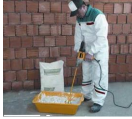
Resim 1.14: Harcın karıştırılması
