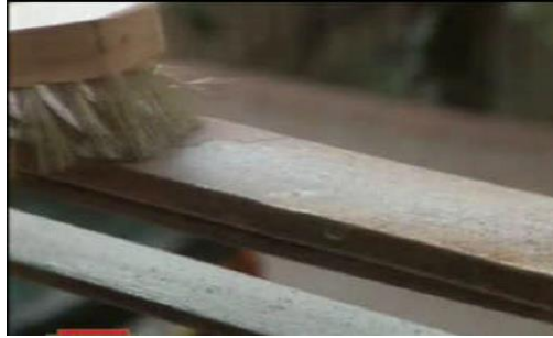
Resim 2.8: Metal yüzeyin tel fırça ile temizlenmesi
