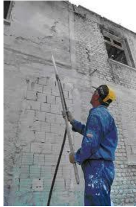
Resim 2.19: Badana pompası ile çalışma
