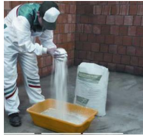
Resim 1.12: Harcın suya eklenmesi
