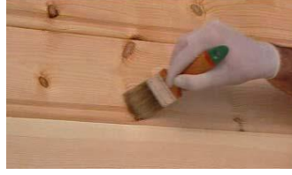
Resim 3.5: Ahşabın lif yönüne sürülmesi
