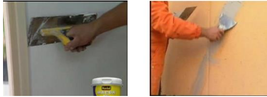
Resim 2.9: Yüzeye macun çekilmesi
