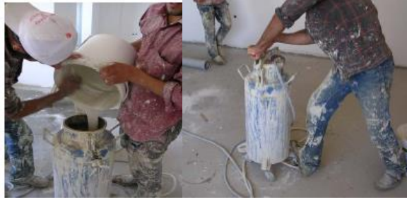
Resim 2.18: Badana pompasının doldurulması
