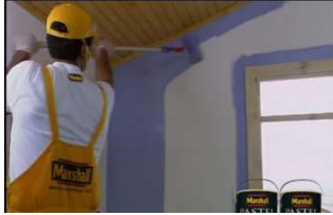
Resim 3.24: Rulo ile boya uygulaması
