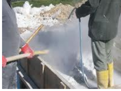
Resim 2.13: Şantiyede kireç söndürme işlemi
