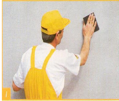
Resim 2.6: Yüzeyin zımpara ile temizlenmesi
