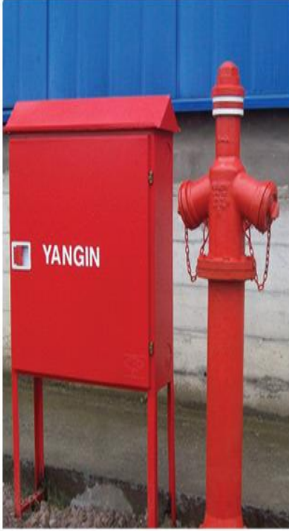
Resim 1.8: Yangın hidrantı
