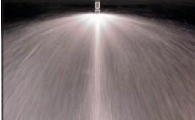
Resim 3.2: Yangın sprinkinin çalışması
