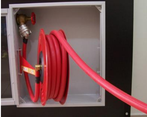
Resim 2.4:Lans (Fiskiye) kontrollü yangın dolabı
