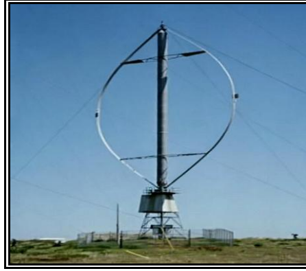
Resim 2.3: Dikey eksenli rüzgar türbini
