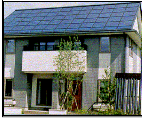
Resim 1.6: Fotovoltaik sistem uygulanan bir yapı
