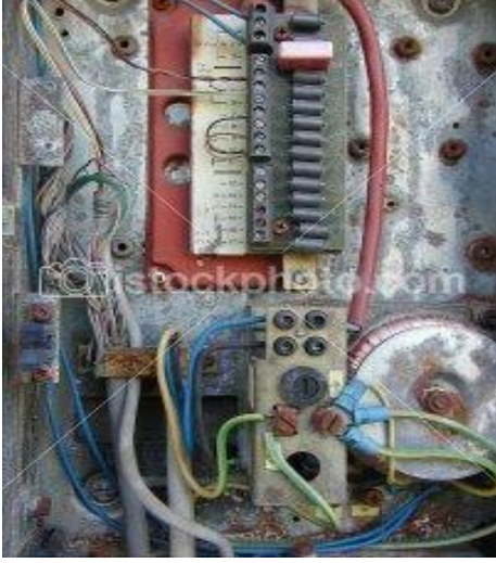
Resim 2.11: Terminal kutularındaki paslanma ve kontrolünün yapılarak onarılması
