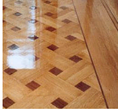
Resim 1.5: Hasır parke uygulaması
