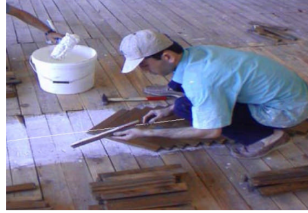
Resim 3.3: Kör döşeme üzerine parke montajı için tutkallın sürülmesi
