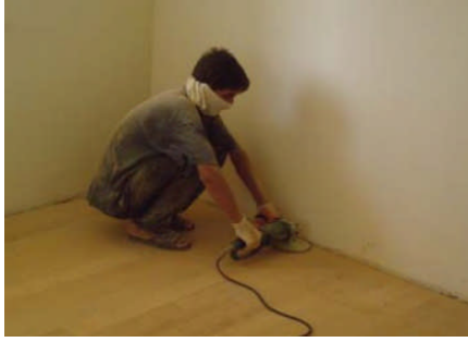
Resim 3.23: Yer döşeme köşelerinin zımparalanması
