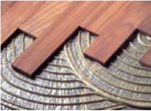
Resim 1.16: Yapıřtırıcı ile yapıřtırılan ahřap parkeler
