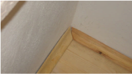
Resim 3.19: İç köşeye süpürgelik çakılması
