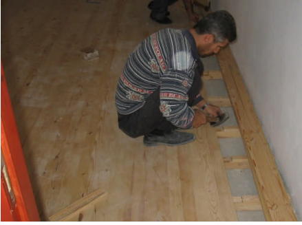
Resim 3.12: Rabita montajı yapma
