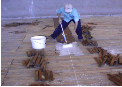
Resim 3.3: Kör döşeme üzerine parke montajı için tutkallın sürülmesi
