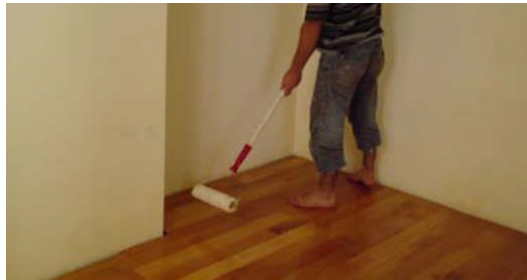
Resim 3.26: Rulo ile cila sürme
