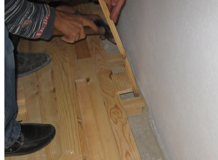
Resim 3.13: Rabita montajı yapma
