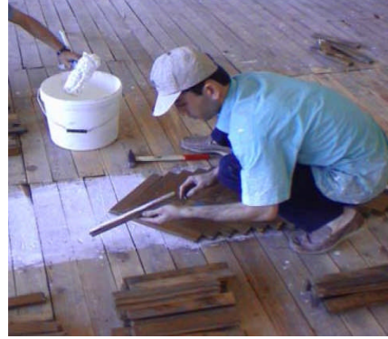
Resim 1.16: Yapıřtırıcı ile yapıřtırılan ahřap parkeler
