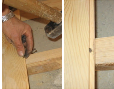
Resim 3.11: Rabıta çivileme aşamaları
