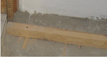
Resim 3.8: Dilme altının kama ile doldurulması
