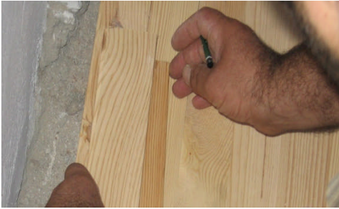
Resim 3.14: Masterla markalama yapma
