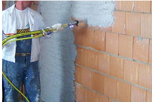
Fotoğraf 2.13: Sıva makinesi ile uygulama
