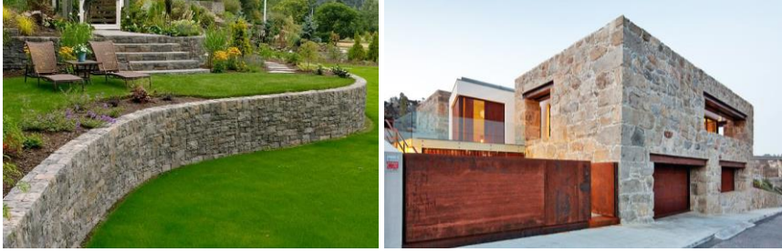
Fotoğraf 2.2: Taş duvar uygulamaları
