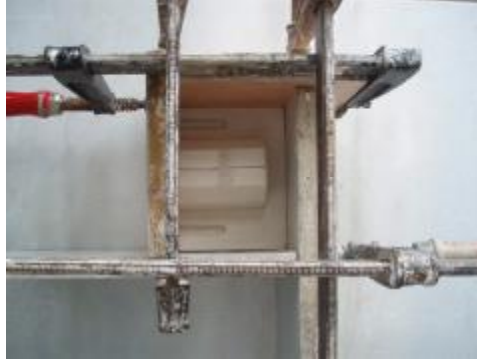
Resim 3.8: İkinci kalıp parçası için döküm alanını oluşturma
