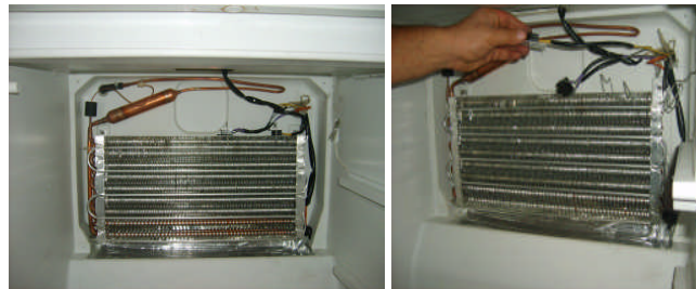
Resim 3.1: No- Frost buzdolabı evaporatörünün montajı
