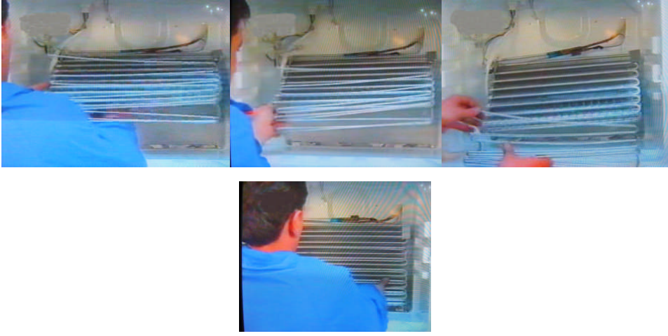
Resim 4.9: Yeni defrost rezistansının yerine monte edilmesi
