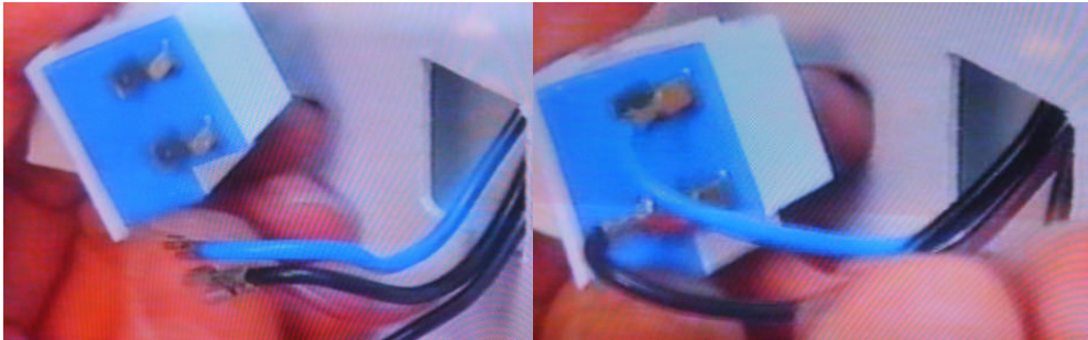
Resim 1.3: Kapı butonu elektriksel bağlantılarının sökülmesi
