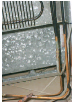
Resim 3.7 : Boru eğimlerinin verilmesi
