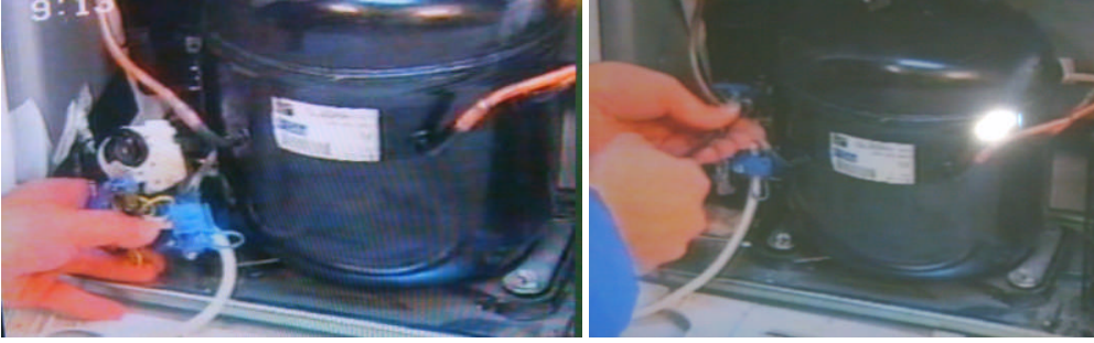
Resim 6.2: Termik ve röle grubunun yerinden sökülmesi
