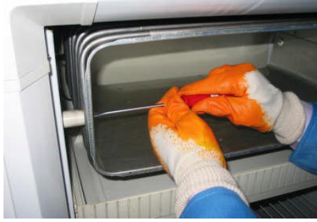
Resim 3.9: Evaporatör montaj vidalarının sökülmesi
