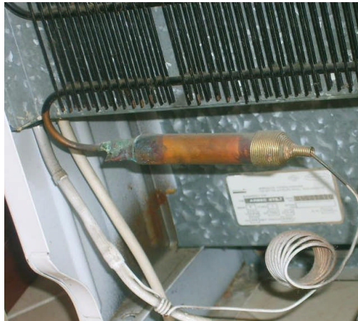
Resim 3.7: Kılcal borunun buzdolabındaki yeri
