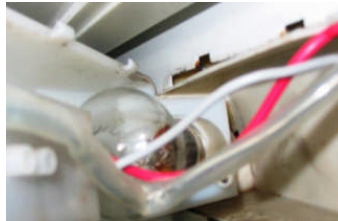
Resim 1.7: Lamba ve duyu bölmesinin sökümü
