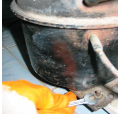
Resim 3.3: Kompresör bağlantı civatalarının sökülmesi
