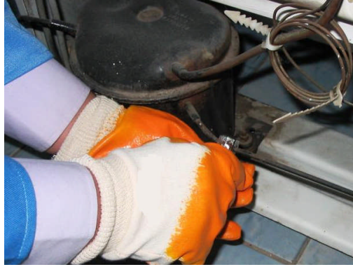
Resim 3.2: Kompresör bağlantı borularının kesilmesi
