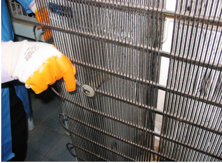
Resim 1.3: Kondenserin montajı
