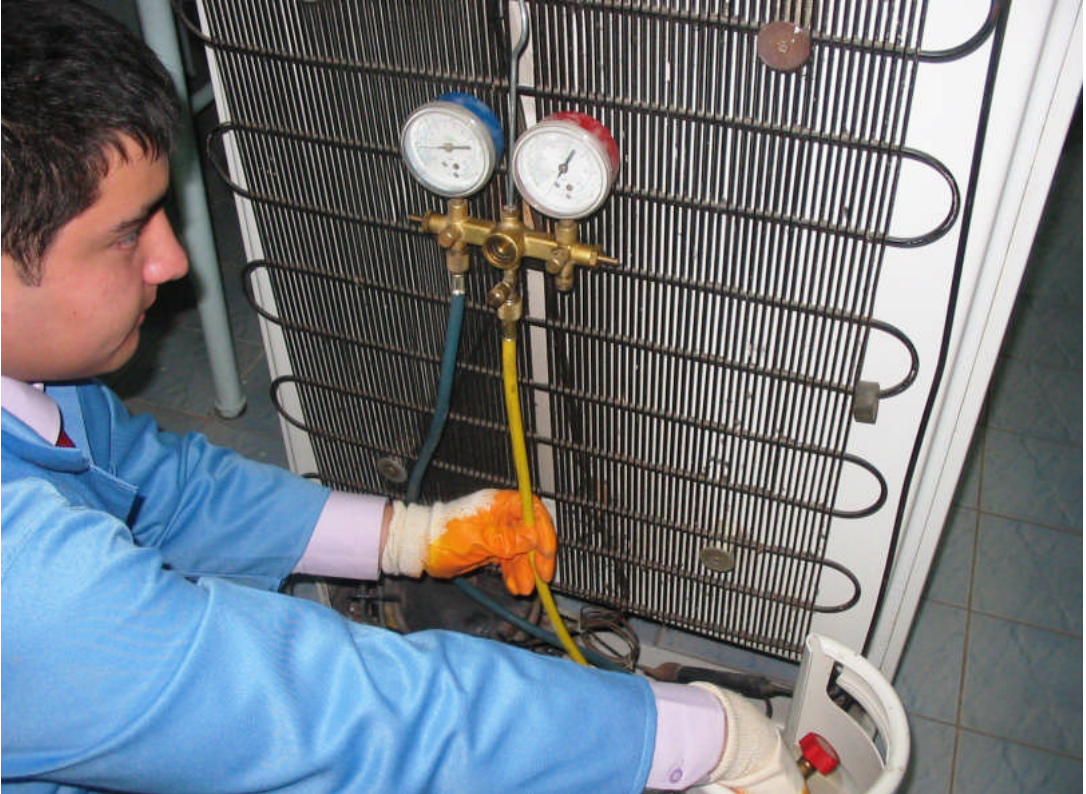
Resim 6.11: Soğutucu gaz tüpünün servis manifolduna bağlanması
