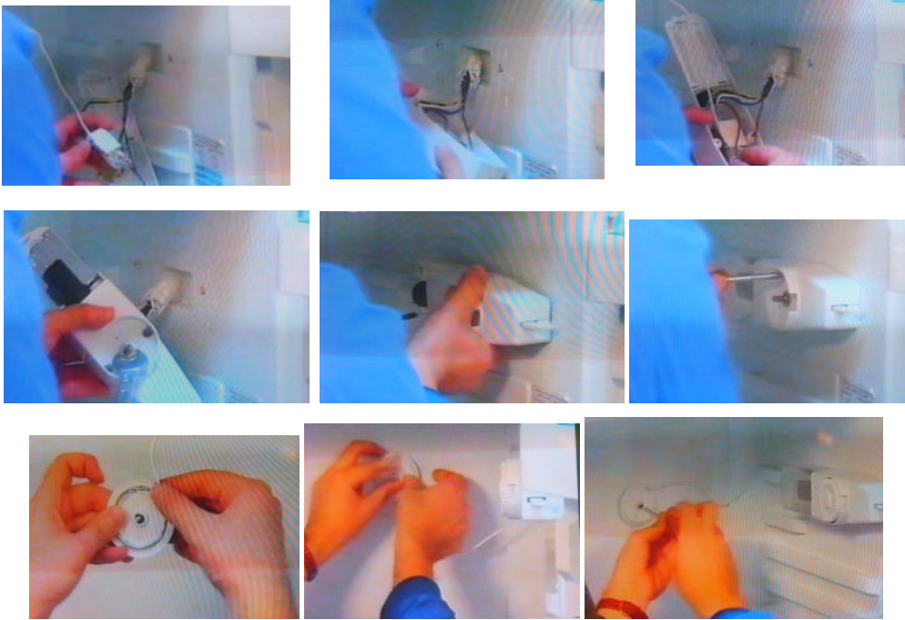
Resim 4.3: Yeni termostatın yerine takılması
