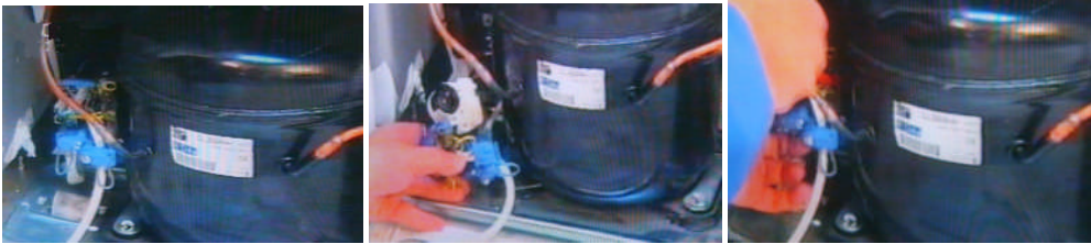
Resim 2.2: Termiğin monte edilmesi
