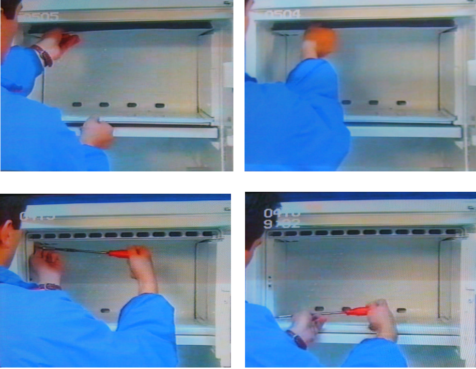
Resim 8.2: Evaporatörün monte edilmesi
